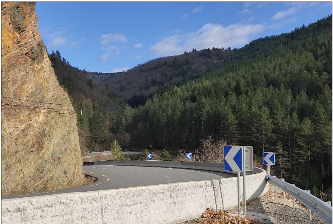
Environnement boisé le long de la RN106
