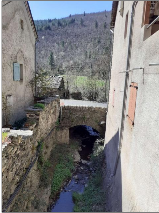
Exemple de pont sur un affluent du Tarn au cœur du hameau de Faux
