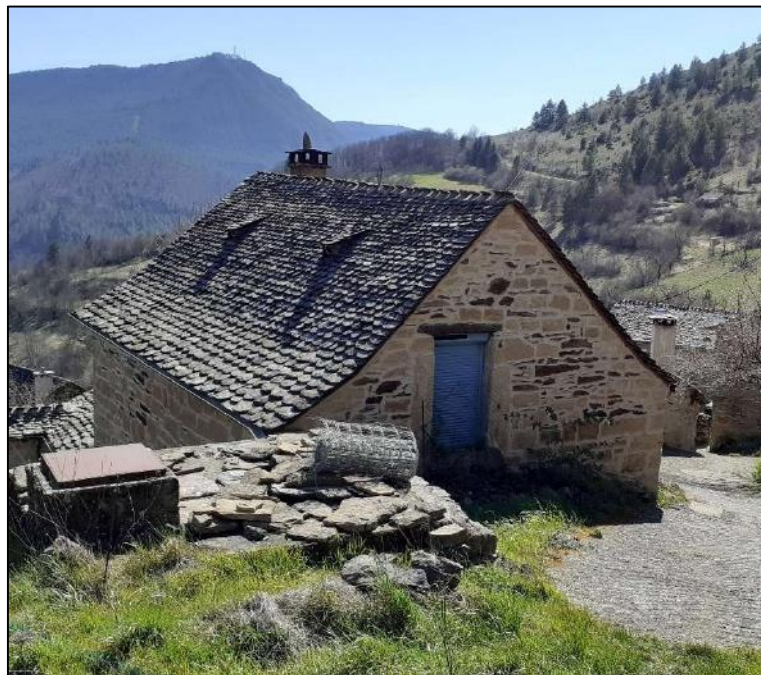
Cheminée à Salanson
