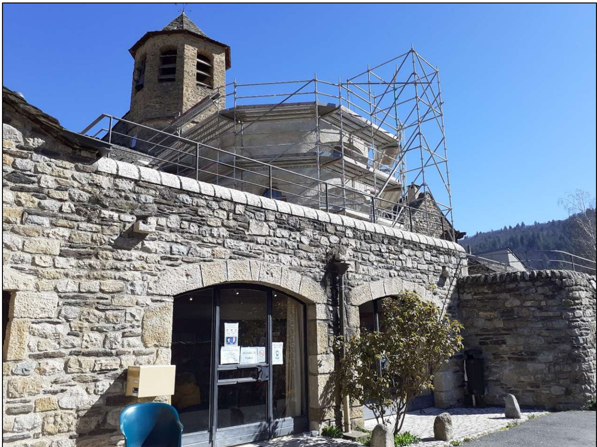
Eglise d'Ispagnac en cours de restauration
