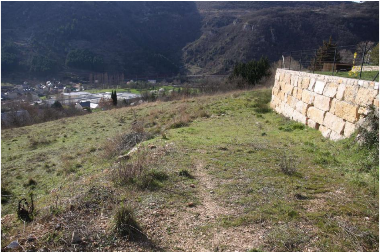
Figure 5 : Les constructions sur pentes demandent parfois des aménagements lourds et coûteux, l'insertion paysagère pouvant être discutable © SIRE Conseil
