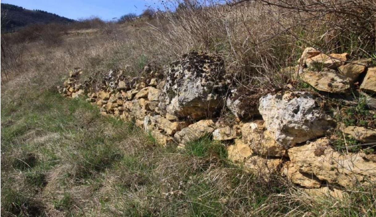
Figure 7 : Le sous-sol calcaire a permis la construction de murs supportant des terrasses © SIRE Conseil 2021
