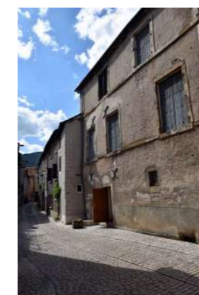
Façade Sud (rue de la Ville)
