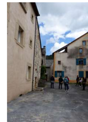
Place du Camard sans aucune végétalisation
