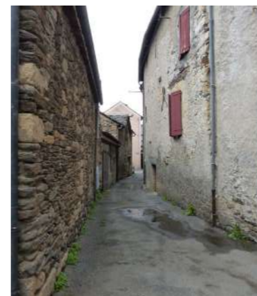
Enrobé seul, rue des Vidourles
