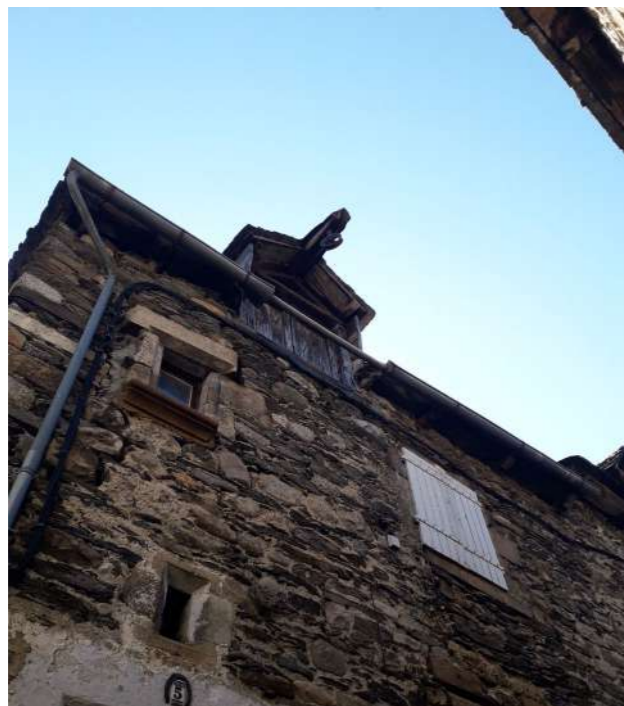
Détails d'architecture qui témoignent des usages passés tels que la poulie pour monter le fourrage dans les combles.
