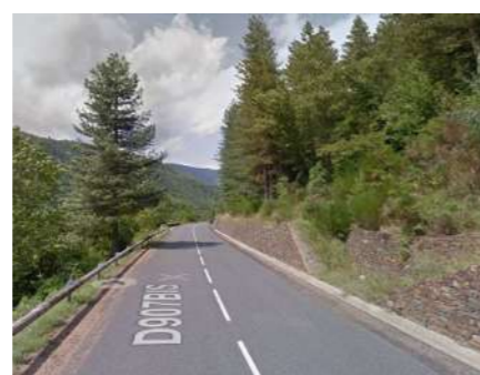
2. RD 907 bis en amont de Faux
